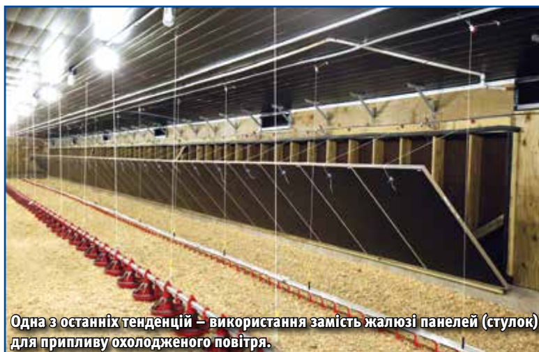
Обов'язковий атрибут сучасної американської ферми — система випарного охолодження.
