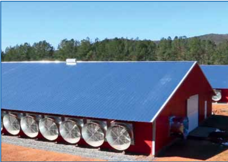
Фото 4. Витяжні вентилятори зі змінною швидкістю обертання
