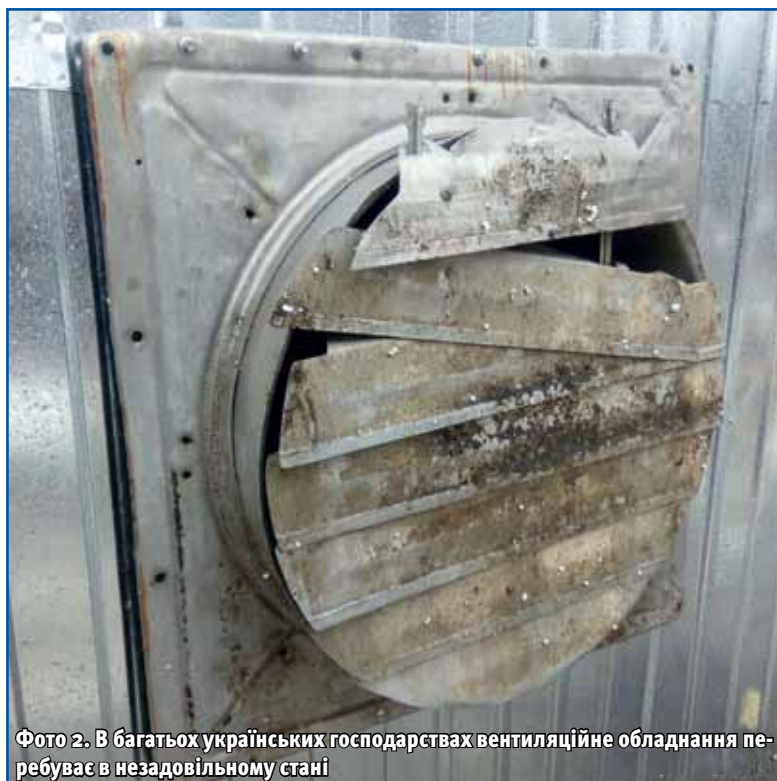
Фото 1. Брудні жалюзі та лопаті знижують продуктивність вентилятора на 10–20%
